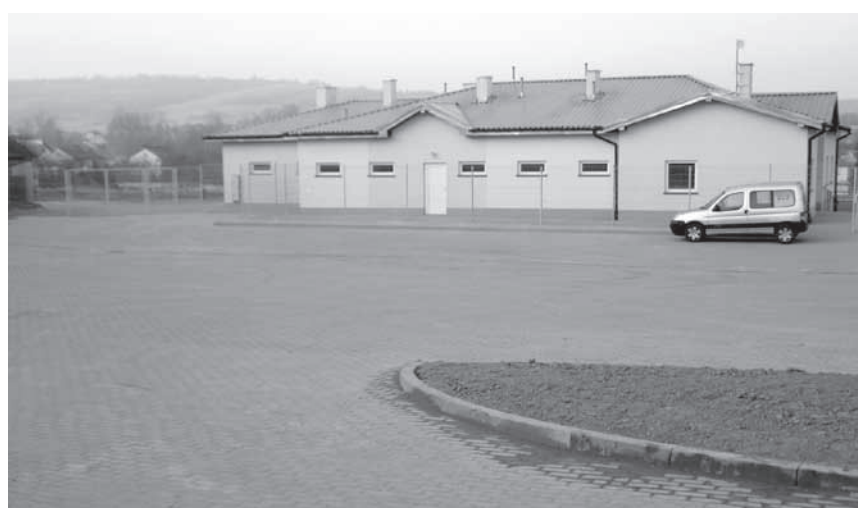
Parking przy ul. Armii Krajowej
