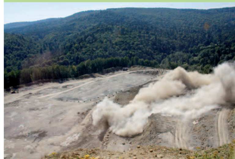
Rozbijanie skał materiałem wybuchowym
