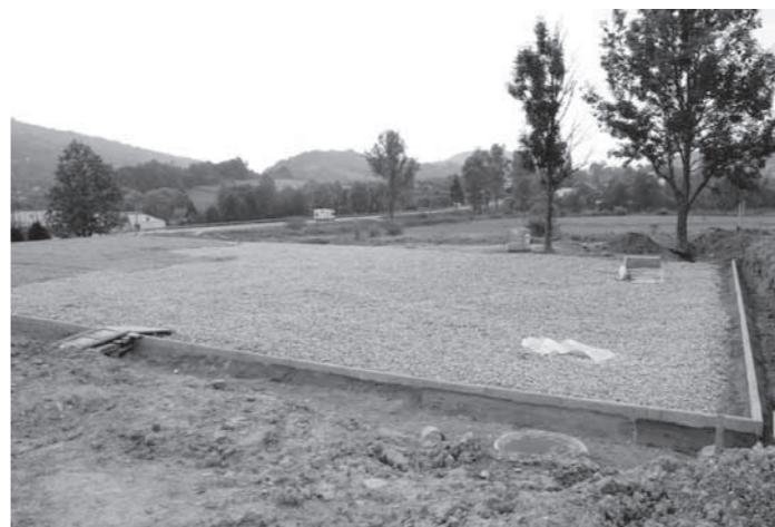
Orlik w Tylawie - rozpoczęcie budowy. Fot. kbr
