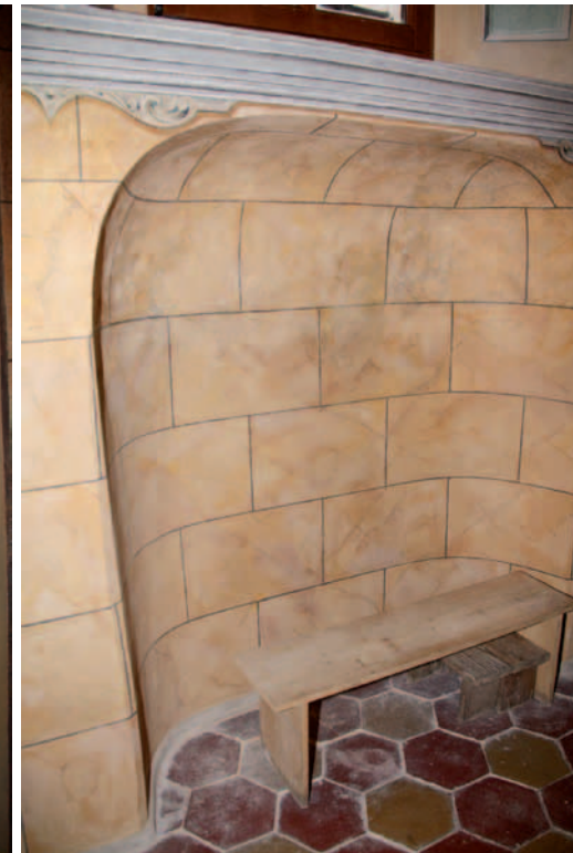
Fragment ściany wschodniej po renowacji
