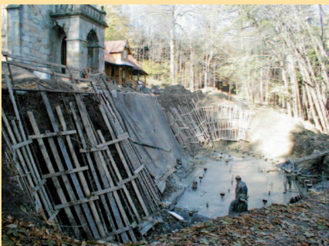
Prace zabezpieczające kościółek przed osuwiskiem ziemnym na Pustelni św. Jana z Dukli w Trzcanie
