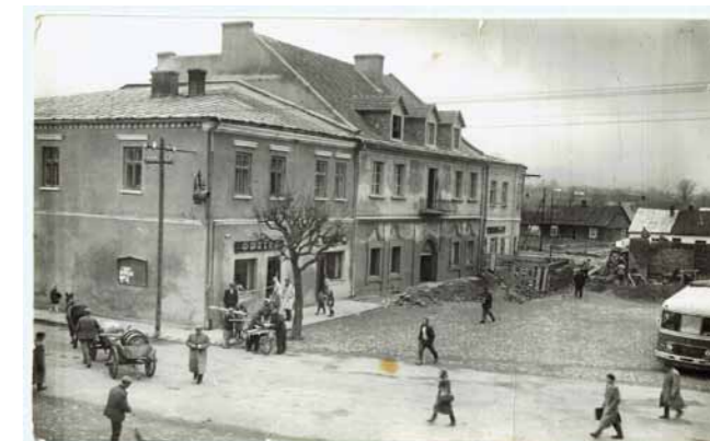
Budynek nr 25 na dukielskim Rynku po odbudowie wiosną 1961 roku
