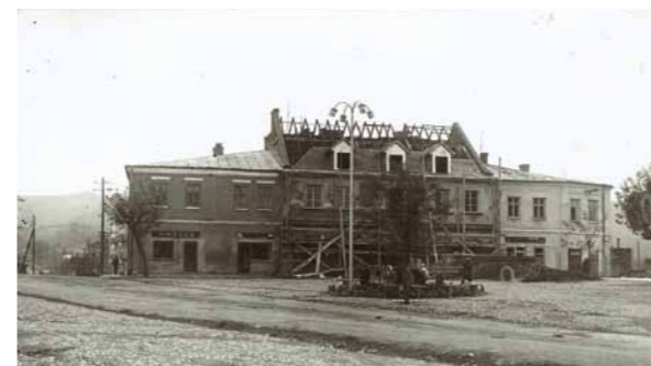
Budynek nr 25 na dukielskim Rynku podczas odbudowy początkiem lat sześćdziesiątych
